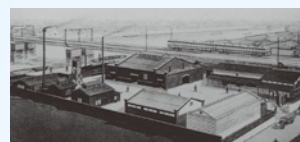
鳴野工場全景
