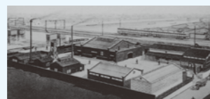
鳴野工場全景
