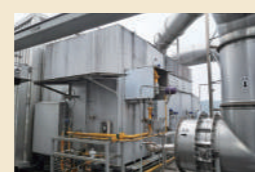
触媒燃焼式脱臭装置(CTO)
