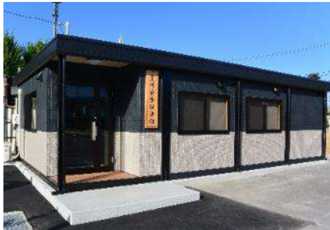
荒川安全伝承館の設置
