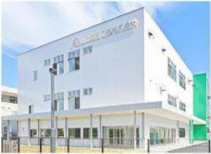
竣工した第2工場。スペックイン作業に入った
